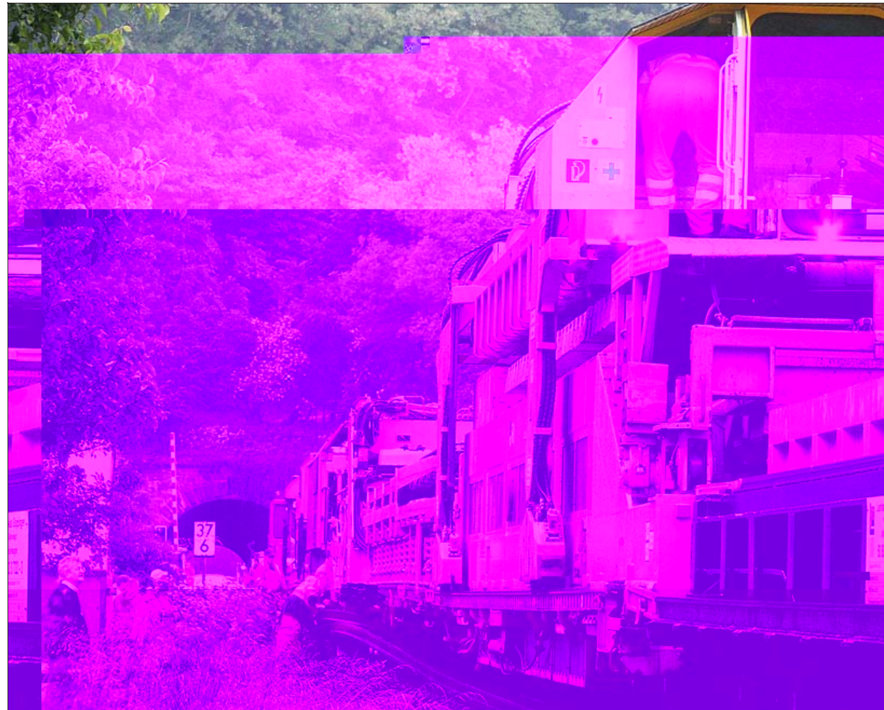
Dieser Umbauzug mit der klangvollen Bezeichnung »Schwoba-Pfeil« macht seinem Namen alle Ehre: Er schafft 200 Schienenmeter in der Stunde. Foto: Priestersbach
