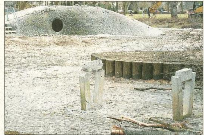
Die Arbeiten haben bereits begonnen. Viel ist nicht mehr zu sehen vom Spielplatz im Kleb. Foto: Hofmann
