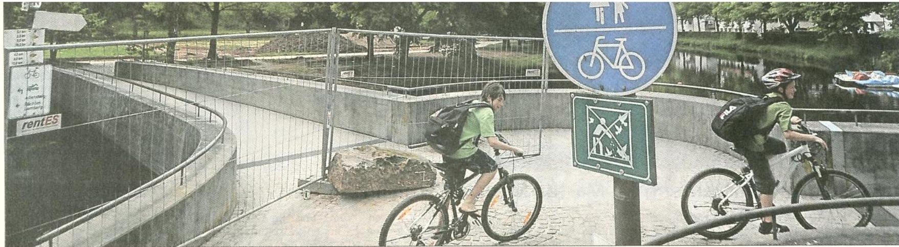
Viele Wege führen zur Burgruine – wenn auch aktuell wegen der Kleb-Baustelle auf Umwegen. Ob künftig aber auch eine Treppe den Schlossberg hinaufführt ist weiter offen. Die Treppengegner setzen auf die Entscheidungen im Regierungspräsidium Karlsruhe. Foto: Fritsch
