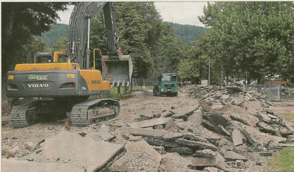
Die Arbeiten auf dem Uferparkplatz gehen rasch voran. Der gesamte Asphalt ist bereits abgebrochen. Als Parkplatz-Alternative empfiehlt die Stadt unter anderem das Teufel-Gelände. Foto: Fritsch
